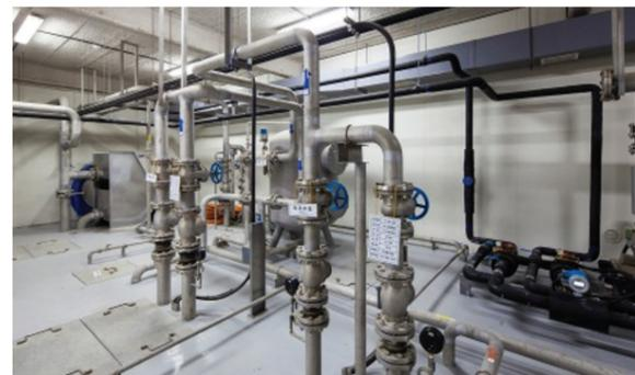
중수/우수 시스템: 건물 옥상 및 대지 내 우수, 지하수를 집수하여 중수 원수 또는 조경수로 재사용하는 시스템
